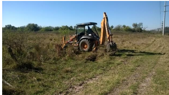
Limpieza de canal secundario. Aporte Vialidad Provincial
