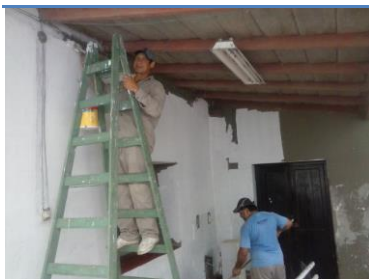
Acondicionamiento del establecimiento.
